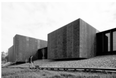
Musée Pierre Soulages - RCR Architectes, Rodez 2014
